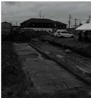
HJ第758次調査 発掘区全景 (北東から)
