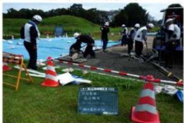
ポーラスコンクリート 締固め
