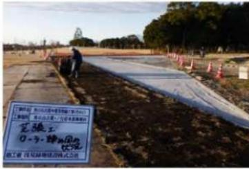
植栽工 (張芝工) ローラー締固め
