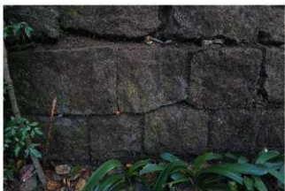
写真1 石垣（亀甲崩し積み・間知石）
