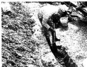
排水溝掘込み作業
