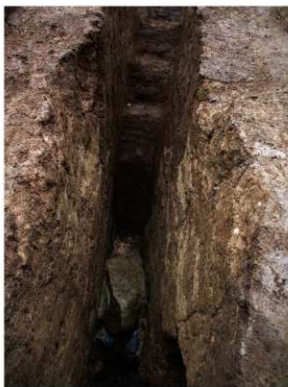
Figure 6 版築と3段の石積み
