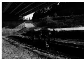
D区 作業風景(北から)
