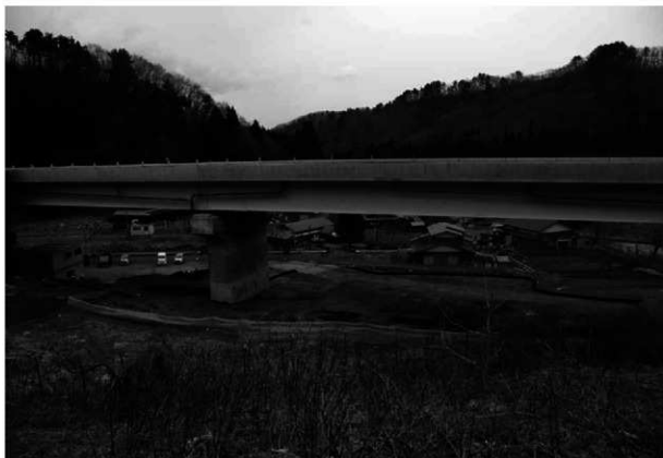
調査区とその周辺(西から)
