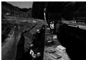
C区作業風景(南から)
