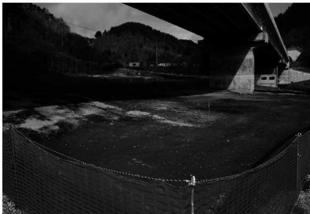
調査前現況(南から)
