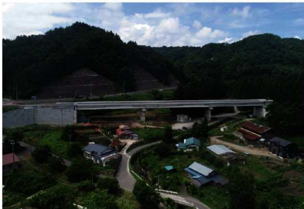
調査区(高架橋下)とその周辺(東から)
