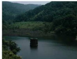
現存する取水塔
