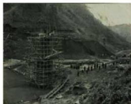
工事中の取水塔
