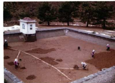
洗浄した砂を敷き直しているところ
