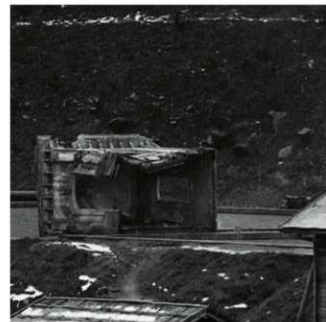
転倒している制水井土家（大正7年）
