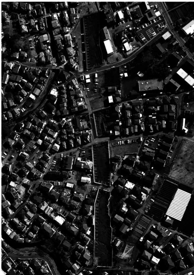
東内手遺跡・北久米遺跡調査区全景
