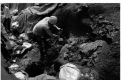
図版 4 崩落岩の削岩作業
