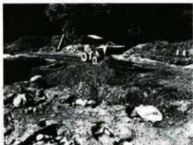
▲ 3. 山砂による邊構面の埋め戻し
