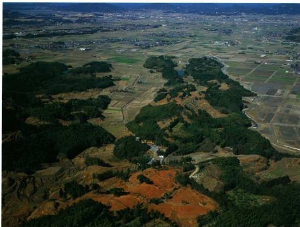
Fig.6 A工区全景（南東から）
