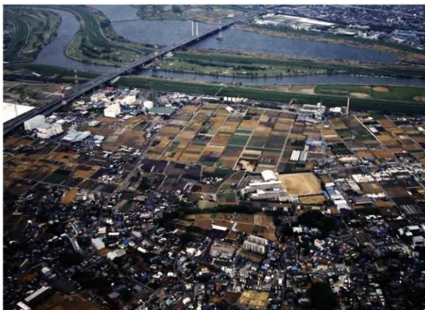
第9次調査空撮 2001(平成13)年
