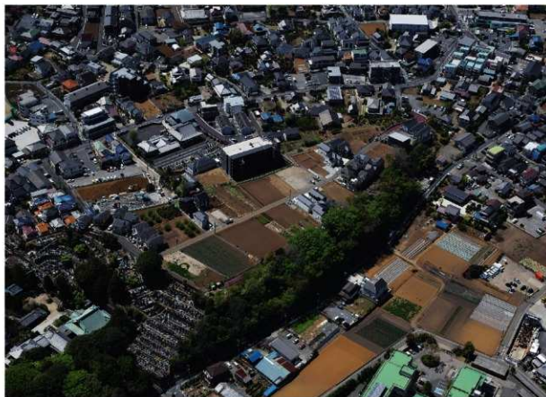
午玉山遺跡空撮北東から 2019(平成31)年4月
