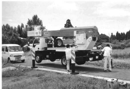
高所作業車での写真撮影
