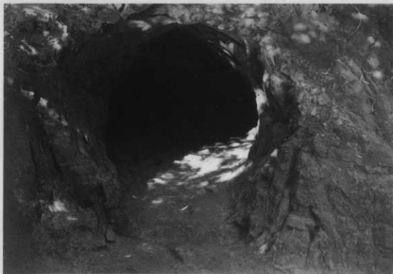
图版5 29号横穴【保存工事着工前】
