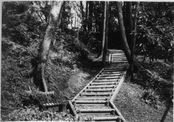
図版69 外周囲路工事(中央谷間から稲荷池奥部)
