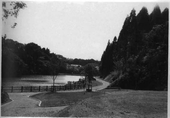
図版66 園路舗装工事③〔稲荷池縁園路〕〔完成〕
