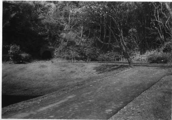
図版52 53号横穴見学道舗装工事[完成]
