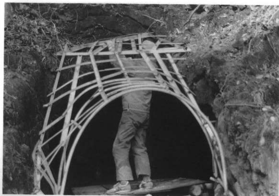
図版36 35号横穴「玄室天井及び護道、羨門口復元ステンレス骨組」
