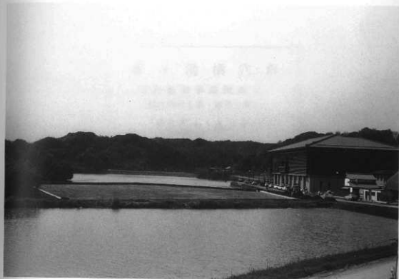
図版74 駐車場整備工事
