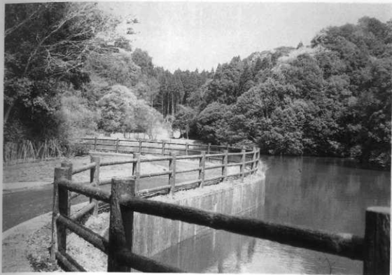
図版65 園路舗装工事②〔御碑防池縁園路〕〔完成〕
