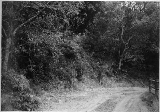
図版54 36~39号横穴前底部補強工事[着工前]
