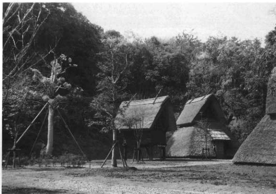
図版67 竪穴住居復元広場修景工事
