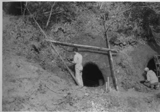
図版30 29号横穴「サイト凝土貼り付け状況」
