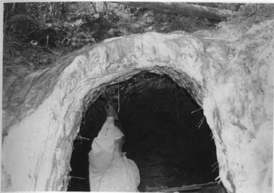
図版37 35号横穴「発泡ウレタン被覆、FRP貼り付け状況」
