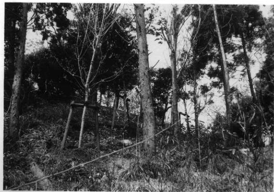
図版60 植栽工事〔12号横穴丘陵植栽〕〔完 成〕
