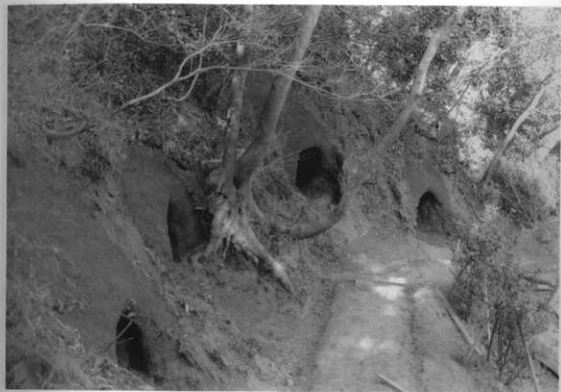
圖版50 29、30、35、31号横穴「保存工事完成全景」
