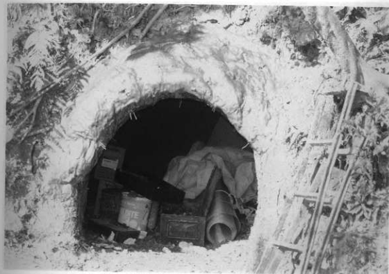
図版42 31号横穴「発泡ウレタン被覆FRP貼り付け状況」
