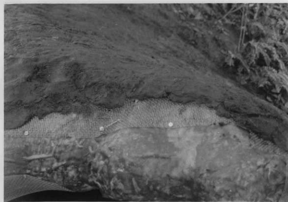
図版13 13号横穴「FRPによるウレタン被覆後の金網取り付け状況」
