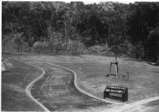
図版68 石塔のはらっぱ整地修景工事
