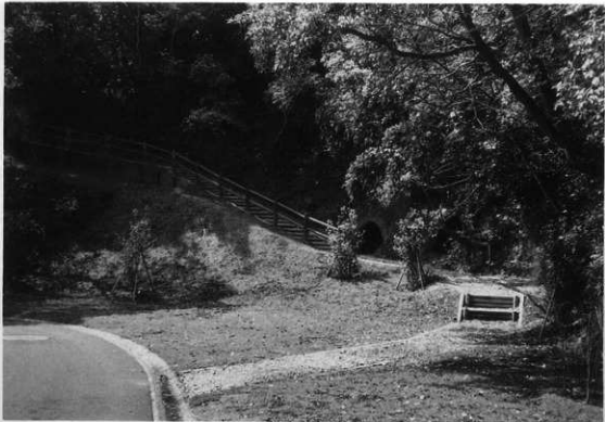
図版56 36~39号横穴見学道設置工事〔完成〕
