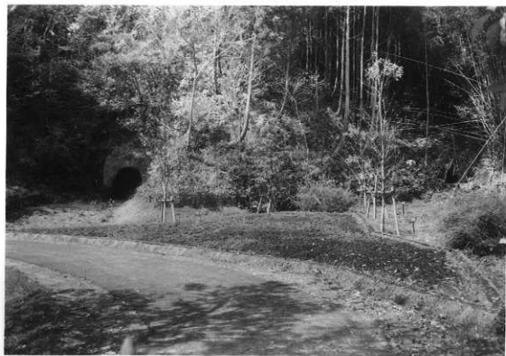
図版51 53号横穴前広場整地修景工事[完成]
