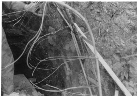
図版11 13号横穴「ステンレス金網固定針金取り付け状況」
