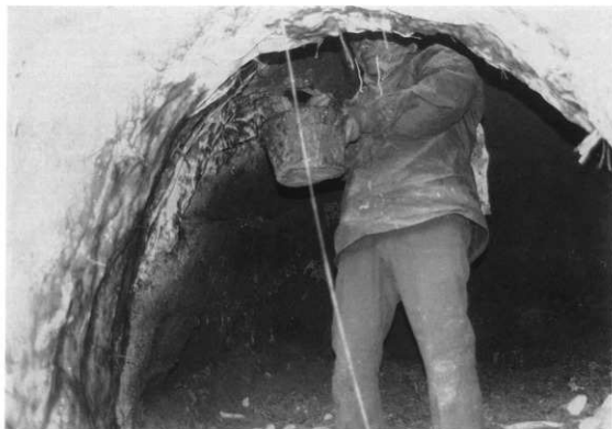
図版27 29号横穴「FRP貼り付け状況」
