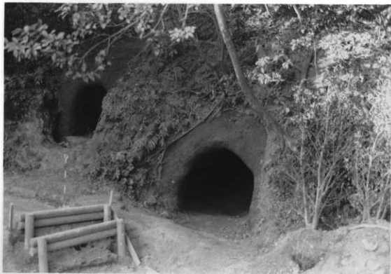
圖版48 35号横穴「保存工事完成」
