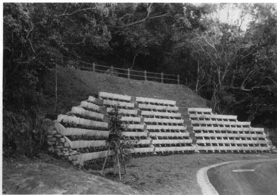
図版55 36~39号横穴前底部補強工事〔緑化ブロック〕〔完成〕
