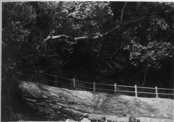
図版57 36~39号横穴見学道安全柵木橋設置工事〔完成〕
