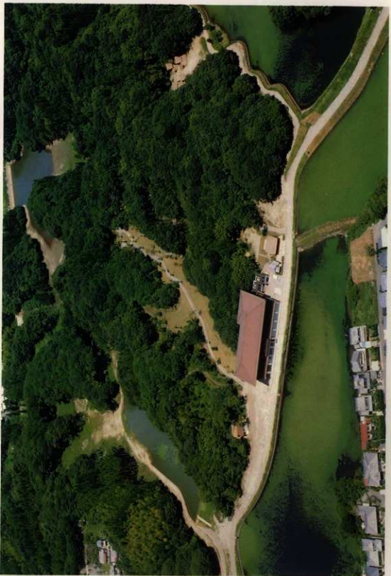
安海鎮空路村大池
