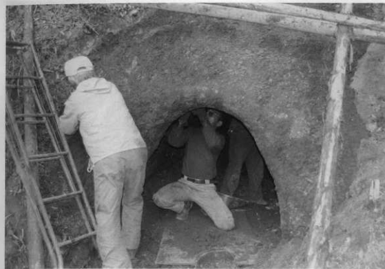
図版29 29号横穴「エポキシ凝土貼り付け状況」
