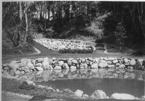
図版61 蓮池及び溼性植物園整備工事〔完 成〕
