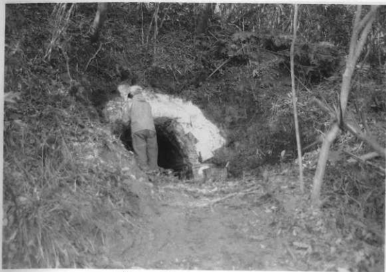
図版21 23号横穴「FRP貼り付け状況」
