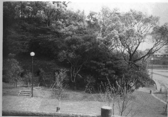
図版62 園内照明工事〔完 成〕
