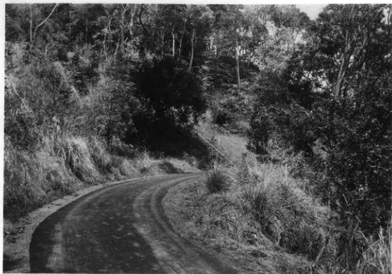
図版59 見学道舗装工事②〔9～11号横穴見学道〕〔完 成〕
