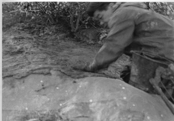
図版14 13号横穴「金網取り付け後のエポキシ凝土貼り付け状況」
