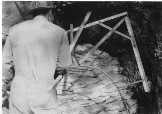
図版48 71号横穴「玄室内部に土のう積込後、ステンレスによる羨道部枠組」
