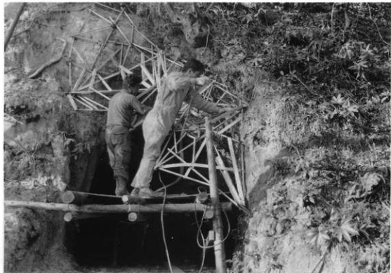
図版44 69号横穴「ステンレスによる玄室天井、渡道部骨組状況」
