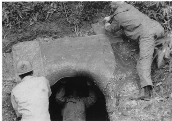
図版16 14号横穴「発泡ウレタン被覆FRP貼り付け後のステンレス金網取付け」
