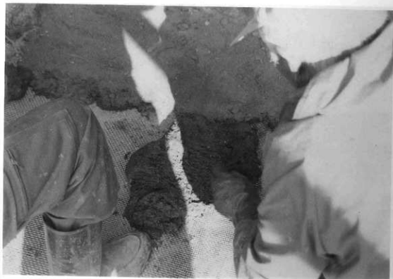
図版42 53号横穴「ステンレス金網貼り付け後のエポキシ罫土押圧貼り付け」
