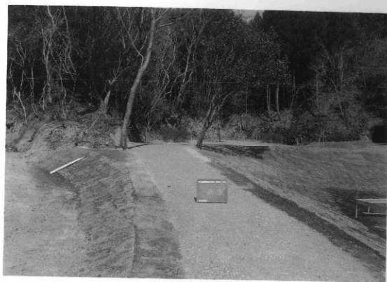
図版79 53号横穴前庭広場園路工事[完成]
