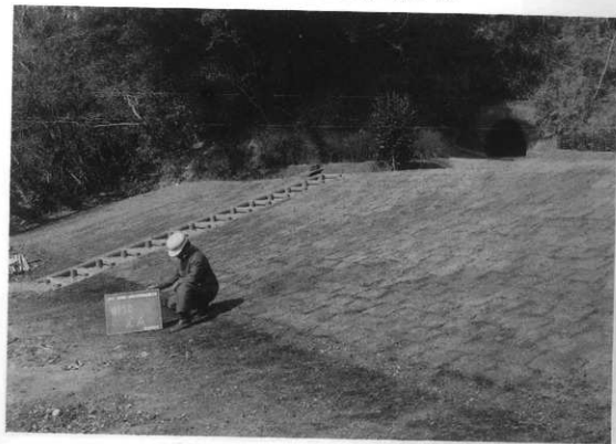
図版80 53号横穴前庭広場園路張り芝工事[完成]
