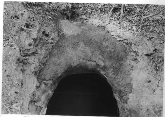
図版54 72号横穴「ステンレス全網貼り付け後のエポキシ掘土押圧貼り付け」
