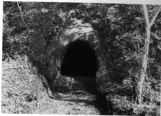
图版73 72号横穴「保存工事完成」
