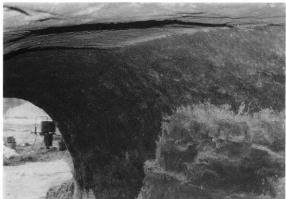
図版40 53号横穴「羨道部から玄室にかかる崩落部のエポキシ罫土押圧貼り付け修復」
