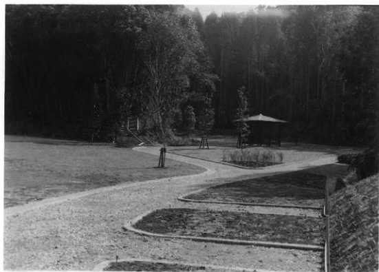
図版85 御諏訪池奥部広場修景工事近景
