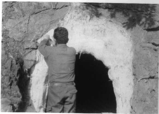
図版29 38号横穴「発泡ウレタン被覆FRP貼り付け状況」
