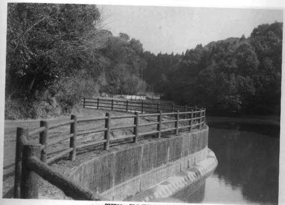
図版88 擬木構設置状況近景
