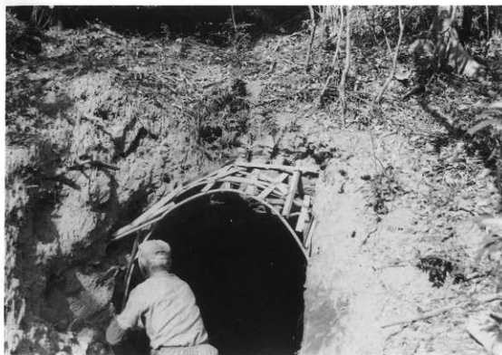
図版51 72号横穴「ステンレスによる炭道部骨組状況」
