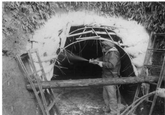
図版32 53号横穴「ステンレスによる護道部骨組後の発泡ウレタン吹き付け状況」
