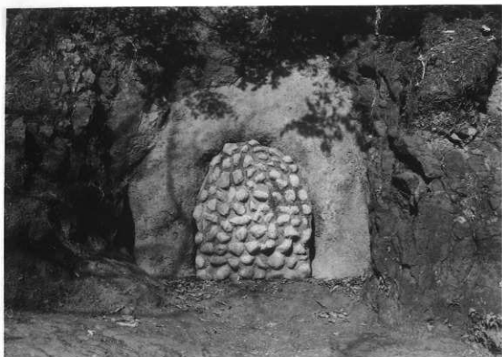
图版67 37号横穴「保存工事完成」
