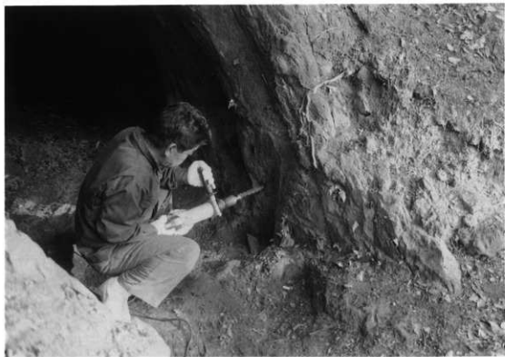
図版27 38号横穴「ステンレス枠組み取付けアンカーボルト打ち込み穴あけ」
