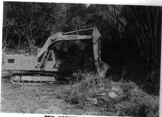
图版76 53号横穴前庭広場修葺工事「除根作業」
