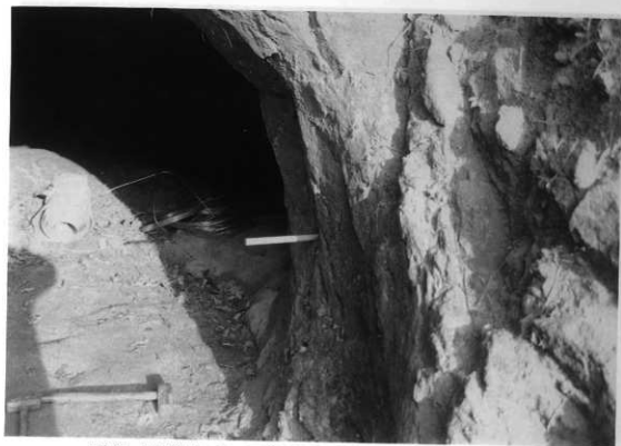
図版25 37号横穴「ステンレス枠組み取付けアンカーボルト打ち込み穴あけ」
