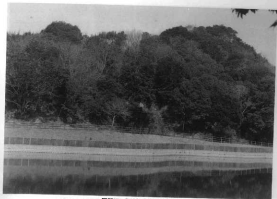
図版87 擬木構設置状況遠景
