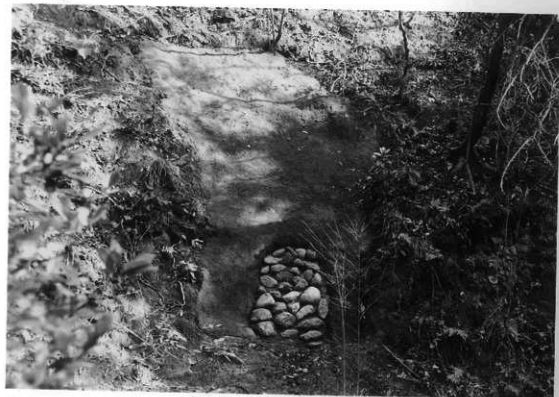
图版74 73号横穴「保存工事完成」
