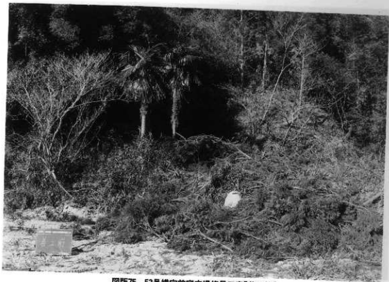
图版75 53号横穴前庭広場修葺工事「着工前」
