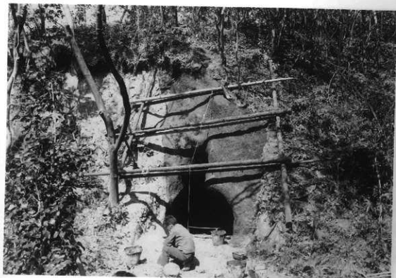
図版46 69号横穴「ステンレス金網貼り付け後のエポキシ凝土押圧貼り付け」
