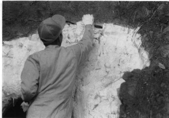
図版24 36号横穴「発泡ウレタン被覆FRP貼り付け状況」
