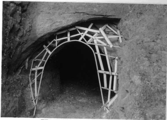
図版21 36号横穴「ステンレスによる後道部骨組状況」
