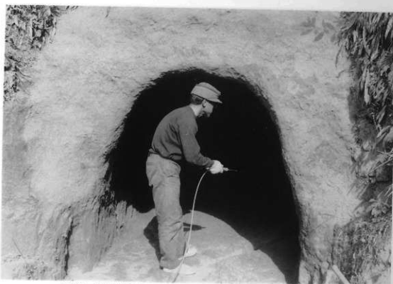
図版37 53号横穴「サイト凝土による仕上げ後の玄室部サンコール含浸」
