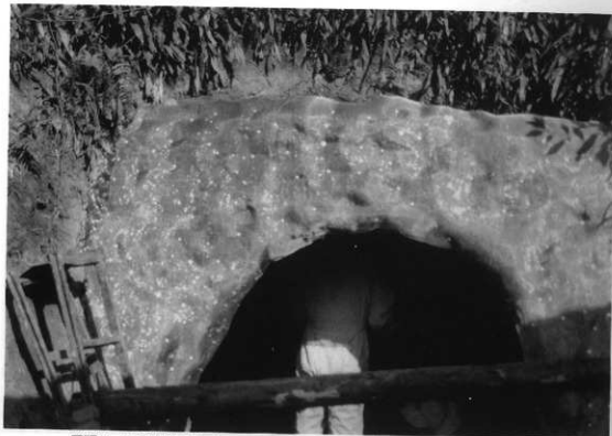
図版34 53号横穴「発泡ウレタン被覆FRP貼り付け後のステンレス金網取付け」
