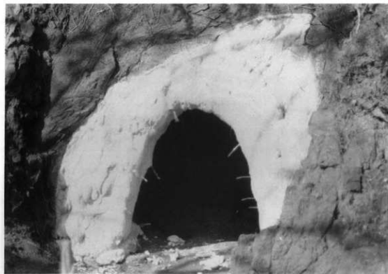
図版23 36号横穴「発泡ウレタン吹き付け」
