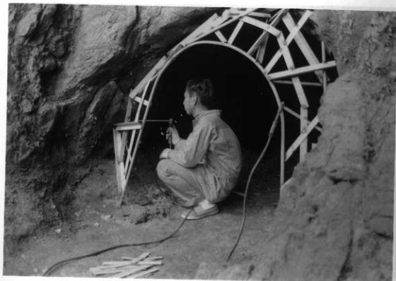
図版26 37号横穴「ステンレスによる炭道部骨組状況」
