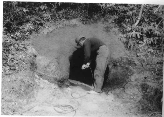
図版18 14号横穴「サイト薬土による仕上げ後の玄室部サンコール含浸」
