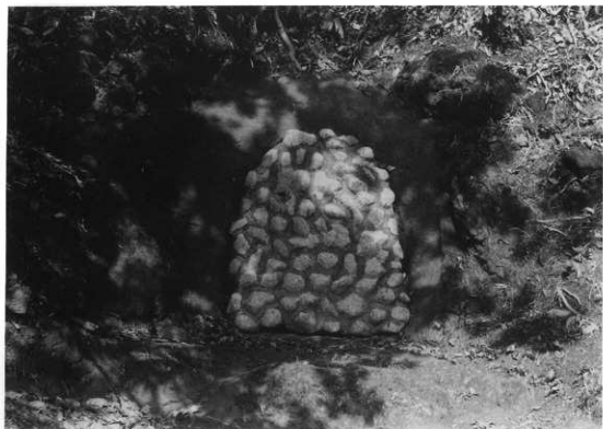
图版63 25号横穴「保存工事完成」
