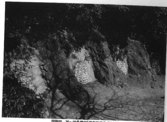
图版65 36~39号横穴「保存工事完成」全景
