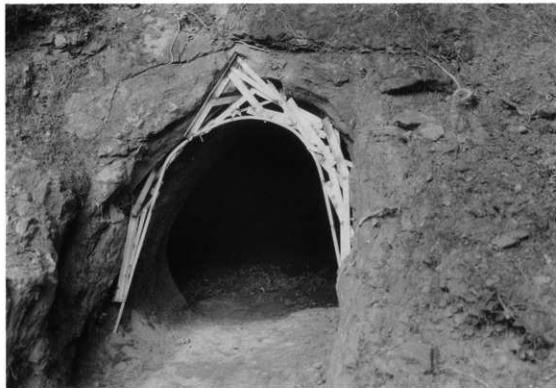
図版28 38号横穴「ステンレスによる羨道部骨組状況」
