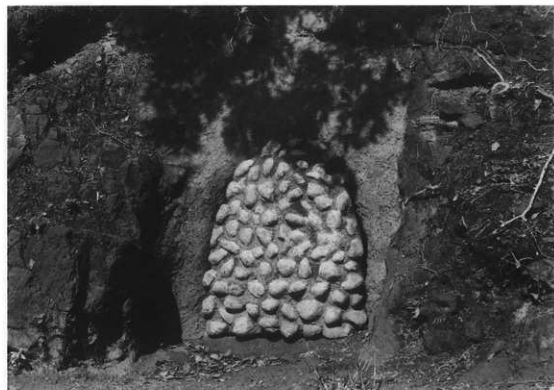
图版68 38号横穴「保存工事完成」
