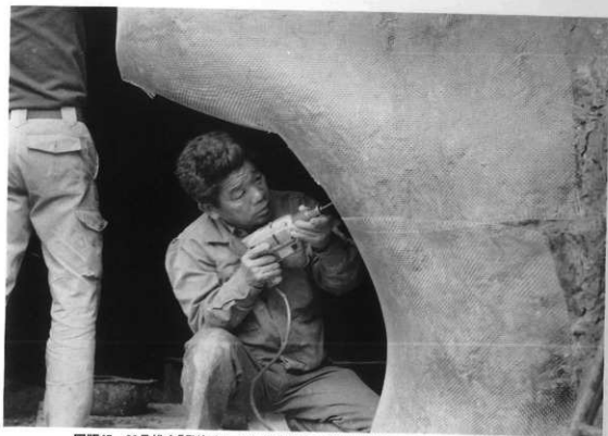
図版45 69号横穴「発泡ウレタン被覆FRP貼り付け後のステンレス金網取付け」
