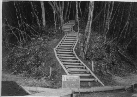
図版92 史跡公園外周園路工事①(完成)
