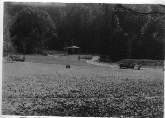
図版84 御諏訪池奥部広場修景工事(芝生舗装、休憩棟、緑台、ベンチ、土舞台、植栽)
