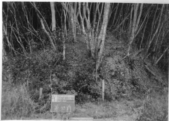
図版91 史跡公園外周園路工事①(着工前)
