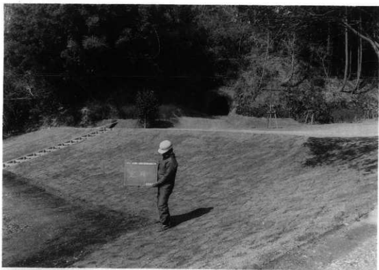
図版77 53号横穴前庭広場修葺工事[完成]
