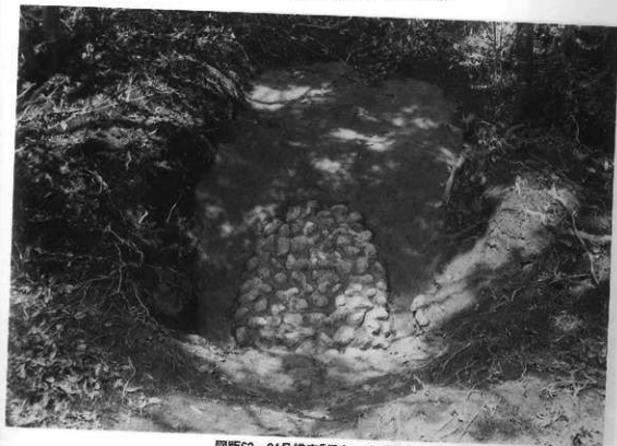
図版62 24号横穴「保存工事完成」
