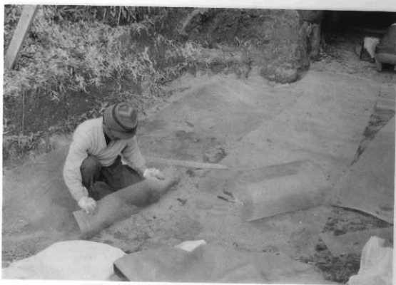
図版41 53号横穴「前庭部床面補強ステンレス金網貼り付け」
