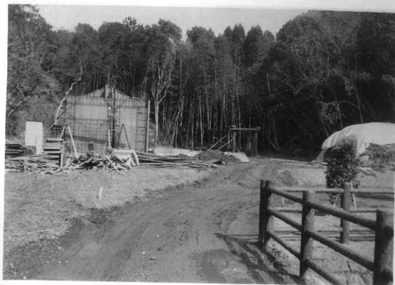
図版83 便所棟仮枠工事(御諏訪池西岸支谷建設)
