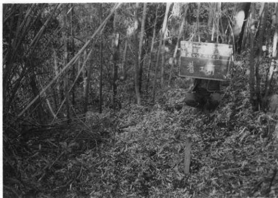
図版93 史跡公園外周園路工事②(着工前)
