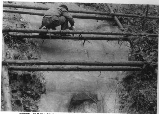
図版57 73号横穴「発泡ウレタン被覆FRP貼り付け後のステンレス金網取付け」
