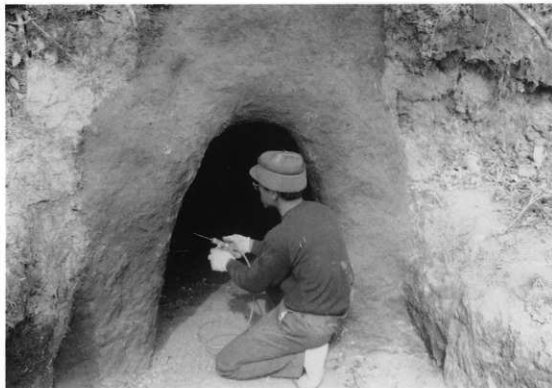
図版20 26号横穴「サイト凝土による仕上げ後の玄室部サンコール含浸」
