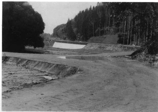
図版90 福荷池西岸見学道築造(北より望む)
