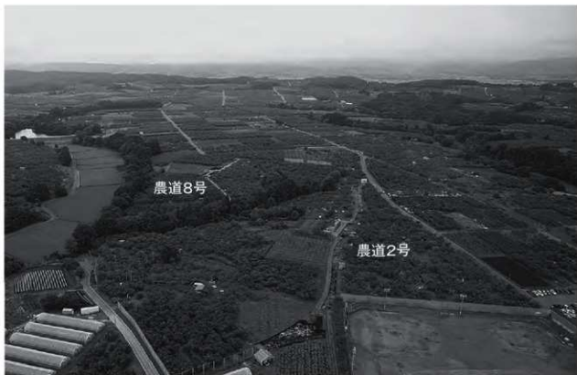
農道2・8号 W→ (手前右が浪岡野沢小学校)
