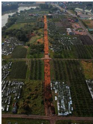
農道1号全景 NE→
