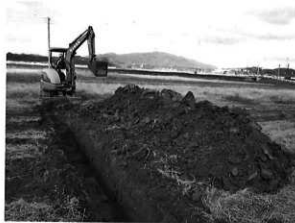
写真1 トレンチ掘削状況
