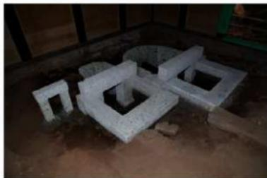
釜組15 竈焚口石積み完了
