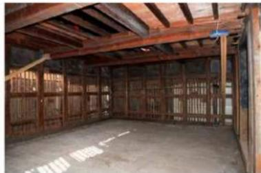
東解35 下段荒壁土・置床解体完了（北西より見る）
