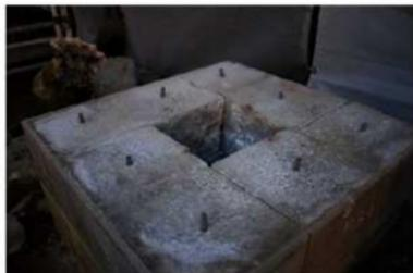
文組2 基礎組立状況（ステンレスダボピン補強）
