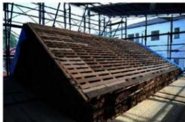
東組13 大屋根小構野地施工完了（北西より見る）
