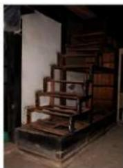
主解54 北東下マ箱階段段段板、蹴込板解体状況
