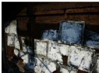
便解10 石積風浅目地入砂漆喰仕上げ解体完了（下部）
