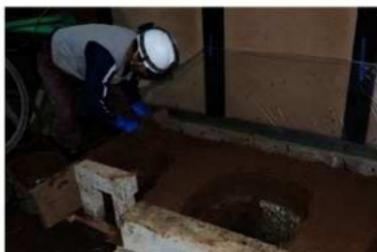
釜組16 竈塗り施工状況
