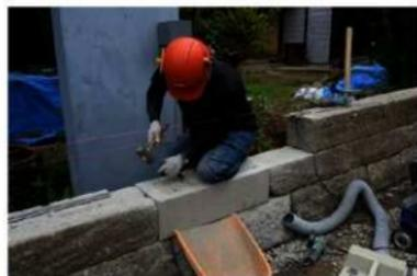
石組16 南塀（西平）補足壁石天端調整状況
