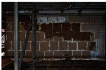
主解59 外壁擬石塗海鼠瓦解体完了
