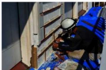
主組46 2階外壁南面擬石塗 日地枠取付状況
