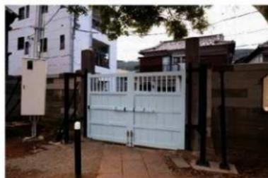
石組36 門扉及び門柱構造補強用支柱設置完了
