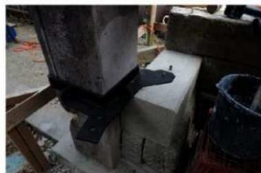
石組28 門柱補強プレート設置完了
