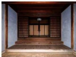
主組92 式台床板復旧及び壁補修完了
