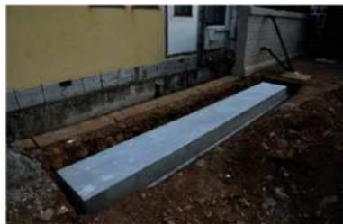
石組42 東板塙耐圧盤設置完了
