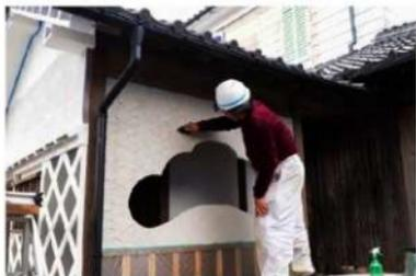
風組18 砂漆噴塗り塗膜波調仕上塗状況
