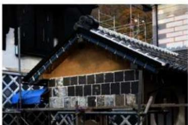
便組18 石積風浅目地入砂漆噴壁下地海鼠瓦施工完了
