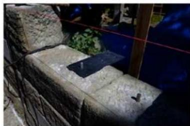
石組18 南塀（西平）壁石構造補強用プレート設置完了
