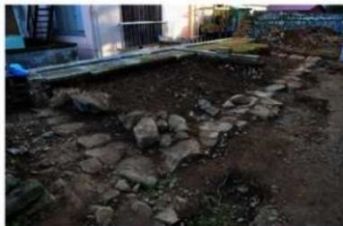
北解41 基礎内部詰込土解体完了
