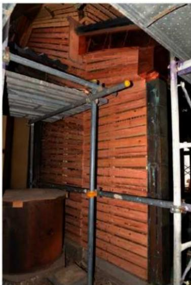
ミ組27 西面外壁掘り直し 木摺下地施工完了
