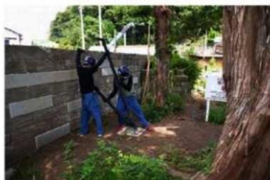
石組34 石塀構造補強用支柱設置状況
