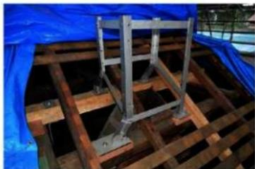
主組24 煙突補強ステンレス鋼材下地状況
