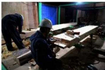
主組10 下屋桁新材加工状況
