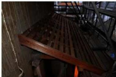
東組25 西面出入口土庇 小舞野地施工完了
