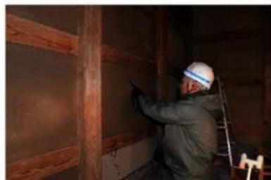
北組45 内部中塗り仕上げ施工状況
