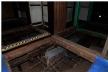
主組87 中央部構造補強耐圧盤
