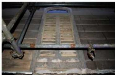
主解56 外壁漆喰塗壁撤去状況
