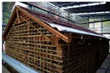
北組30 2階木舞掻き（ツタ掛け割竹・縄絡・下縄）状況
