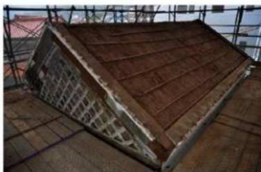
東解6 大屋根棧瓦解体完了、軒先台瓦状況
