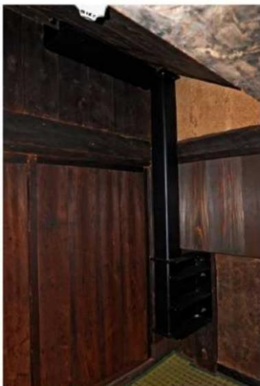
ミ組44 構造補強鉄骨設置完了
