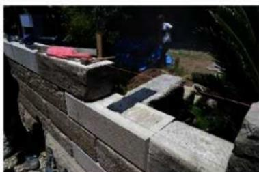
石組19 南塀（西平）、庭塀取合い構造補強用プレート設置完了
