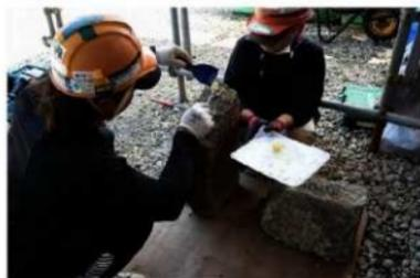
石組12 壁石接着補修状況
