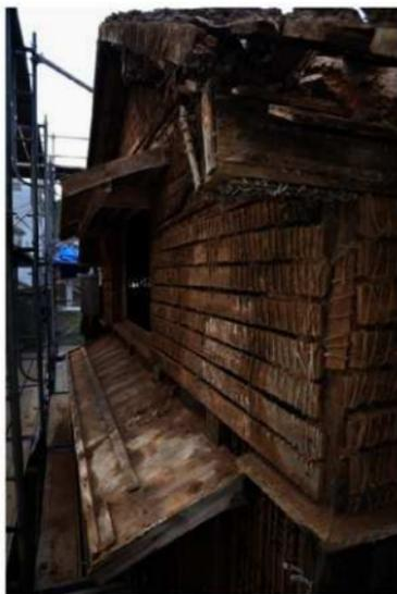
ミ解28 外壁漆喰壁解体完了
