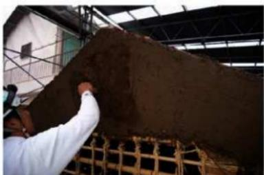
北組38 蟻み亀裂防止欄縄織埋め込み状況
