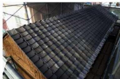
北組24 大屋根根椋瓦平葺完了
