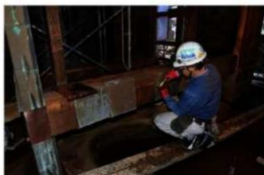
文組46 鋼板葺下屋 差敷居 鋼板包み施工状況
