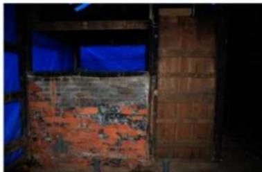
釜解9 後補間仕切り（大正頃）煉瓦積み
