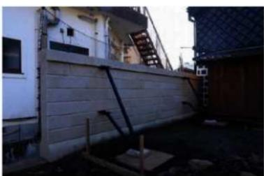
石組39 東塀構造補強用支柱設置完了
