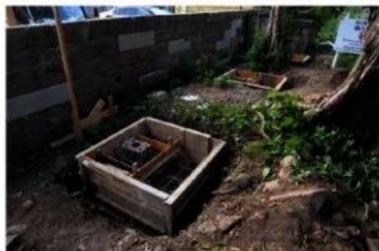
石組32 石塀支柱用耐圧盤配筋状況
