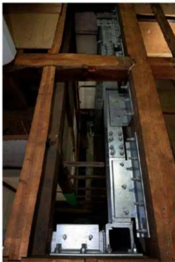
主組89 中央部鉄骨建方完了（2階南西八畳間より見る）
