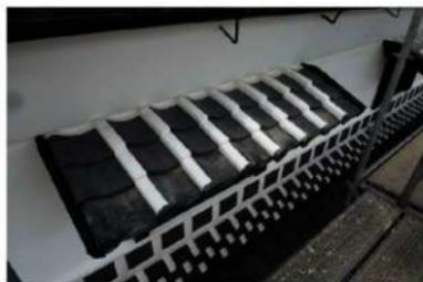
北組28 2階窓庇瓦葺及び棒漆喰施工完了
