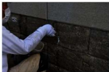
石組26 接着補修 擬石モルタル振り込み状況
