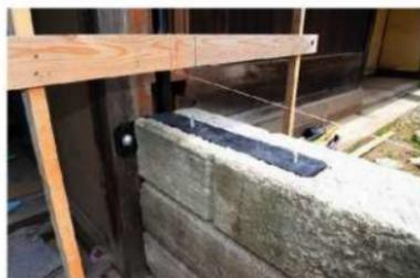
石組20 庭塀一台式台柱繋結用プレート設置完了
