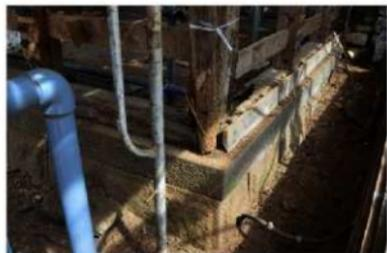
北解26 柱脚・土上の腐朽状況
