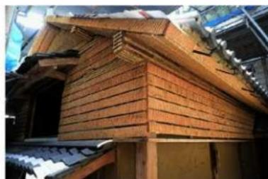
ミ組24 外壁縄巻木摺施工完了
