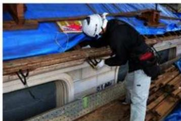
主組33 大屋根軒挿受け金具取付状況
