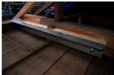
文組10 小屋根梁補修及びステンレスアングル鋼材補強完了
