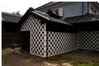
釜組20 海鼠壁施工完了 (北東より見る)
