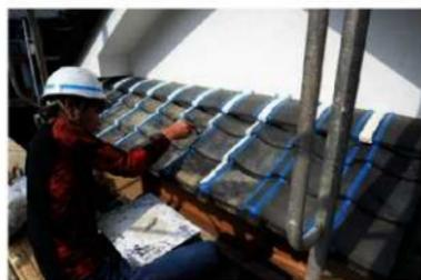
ミ組19 2階窓庇 漆塗り施工状況
