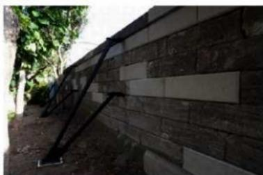
石組35 石塀構造補強用支柱設置完了
