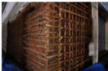
主組42 2階北東外壁木舞下地補修完了
