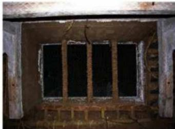
北解18 2階虫籠窓漆喰塗解体状況
