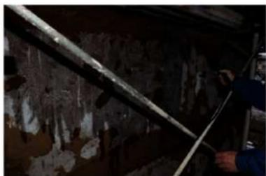
文組31 外壁（北面）砂摺含浸強化剤塗布状況
