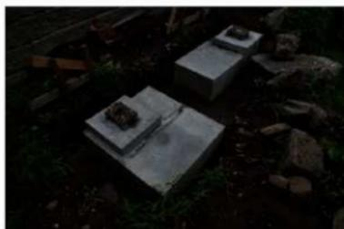
石組33 石塀支柱用耐圧盤コンクリート打設完了
