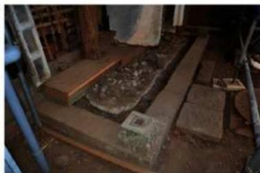
東組6 西面出入口 杵石、縁石 据直し完了
