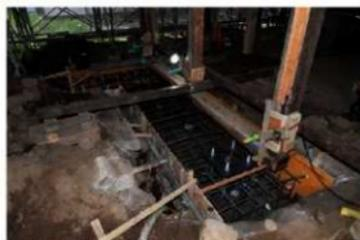
主組84 北東隅部構造補強前圧盤配筋状況
