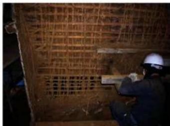
北解16 荒壁土解体状況（南面1階底廻り）
