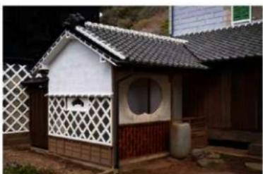
便組22 外壁左官仕上げ及び杉皮網代張施工完了
