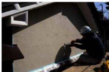
便組20 石積風浅目地入砂漆噴仕上施工状況
