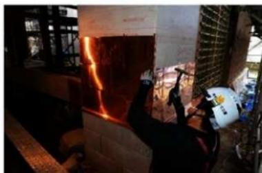
文組47 同左壁 鋼板包み施工状況
