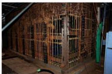
東組4 土台補修（一部取替）、柱高根継完了
