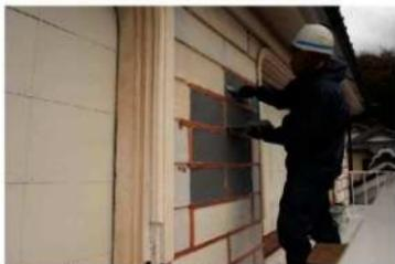
主組47 2階外壁南面擬石塗 上塗り状況
