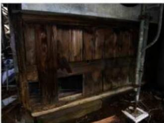
便解25 南面壁下外壁新建材外装解体完了
