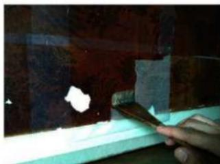
主組62 2階応接間襖剥落止め状況
