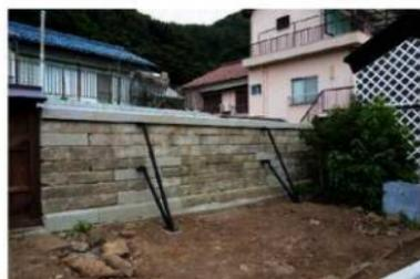
石組38 北塀構造補強用支柱設置完了
