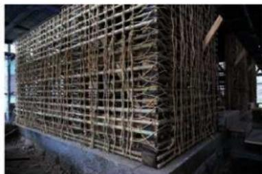
北組32 1階木舞掻き（ツタ掛け割竹・縄絡・下縄）状況
