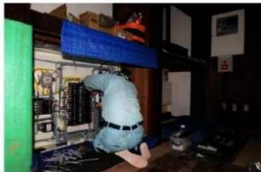
ミ組41 1階押入れ内 分電盤設置状況
