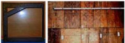
写真 4-4-5-11 主屋 2 階ガラス欄間[108]（修理前） $352 \times 340 \times 20$
