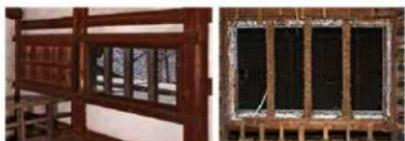
写真4-4-5-6 北土蔵2階窓金網張り（工事中）
