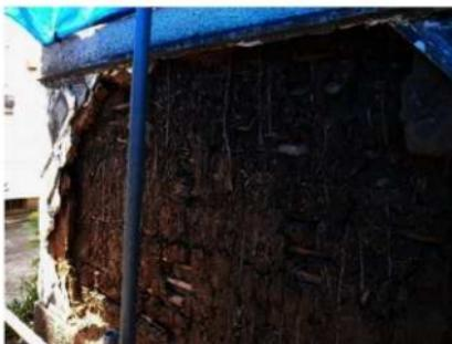
写真3-4-2-2 平成21年地震による東土蔵海鼠壁の崩落
