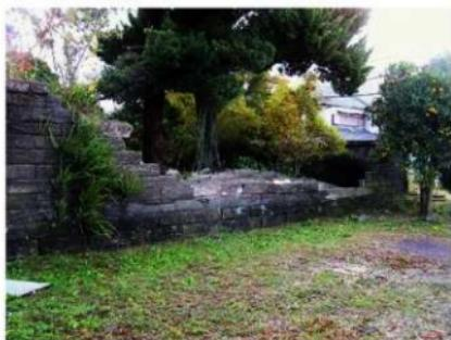
写真3-4-2-3 平成16年台風による西側石垣の倒壊
