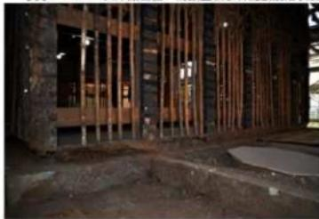
写真 4-1-1-5 東土蔵北面 土台腐朽状況
