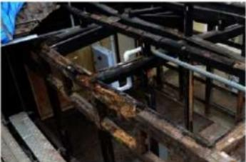
写真 4-1-1-2 主屋釜屋 桁及び差鶴居腐朽状況
