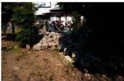
写真3-4-2-1 平成21年地震による東側石垣の倒壊
