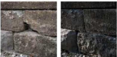
写真3-2-14-2 表面肉盛補修 捲修前(左)と捲修後(右)
