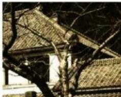
写真 4-4-3-7 明治末～大正主屋、ミセ目地漆喰状況 (古写真 2 扱)
