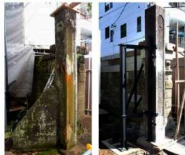
写真3-2-14-3 門柱 修理前(左)と肩吊り柱設置後(右)
