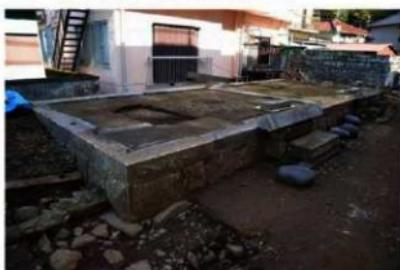
写真 4-4-1-6 北土蔵基壇石組と根石確認
