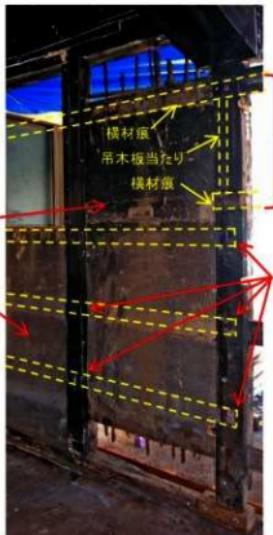
釜10 北面柱に残る棚痕跡（室内）
