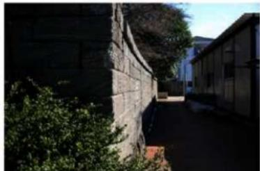
写真4-1-1-7 南堀 傾斜及び波打ち状況
