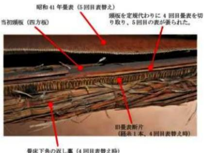
写真 4-4-6-5 現状畳表下の手縫い床（側面長手）
