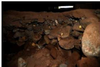
写真3-4-1-3 主屋中央押入下地業断面
