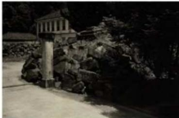
写真6 鳥取大地震で崩壊した太鼓御門石垣
