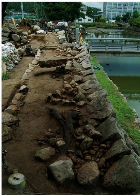
土堀基礎状遺構 (北西から)
