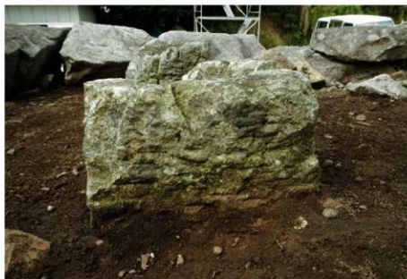
控柱根巻き8設置状況 (南東から)
