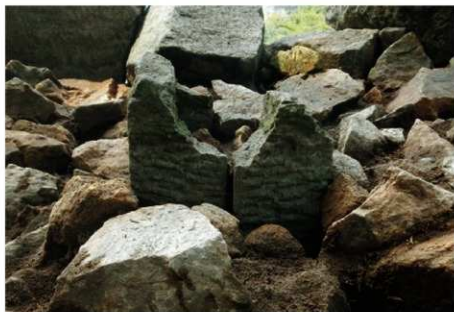
控柱根巻き3設置状況 (北東から)
