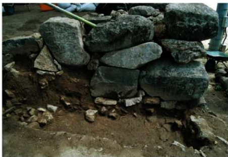
J面石垣検出状況 (南西から)
