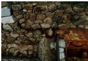
旧石垣検出状況(南西から)
