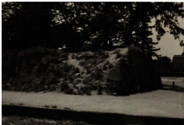
写真3 地震による崩落状況(第1調査区)
