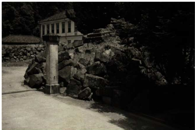
写真4 地震による崩落状況(第4調査区)
