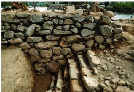
階段検出状況2 (北西から)
