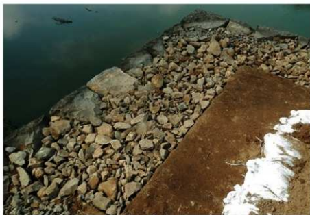
石垣修理状況 A面上面(北東から)
