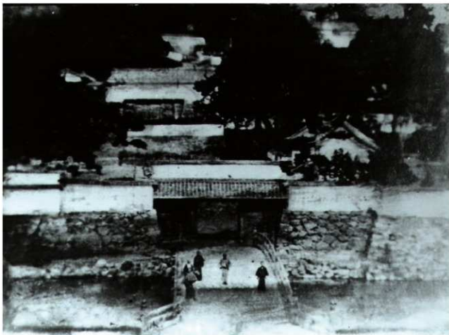
写真2 解体前の鳥取城(正面が中ノ御門)
