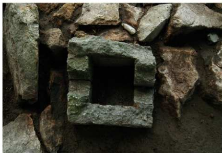
控柱根巻き1設置状況 (北東から)
