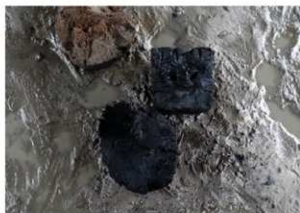
柱56・57・59(南西から)
