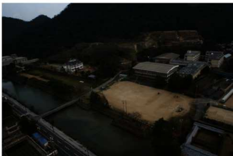
写真1 中ノ御門周辺の現況
