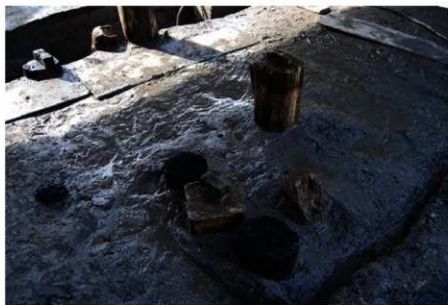
柱3・7・10・11・13(北から)
