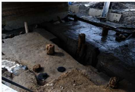
第1調査区(東から)
