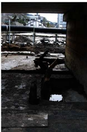
第1調査区柱16～22・66～68(北西から)
