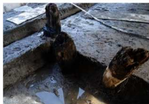
柱16・19・20(南から)
