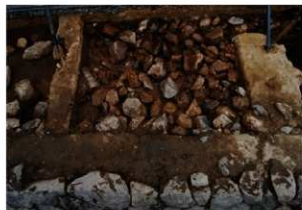
栗石検出状況(南東から)
