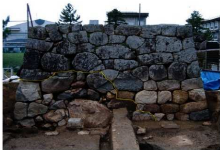
第81図 中ノ御門櫓門脇石垣積み替え状況
