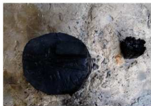
柱37・39(南西から)
