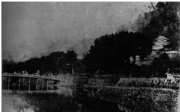
写真3 解体途中の鳥取城
