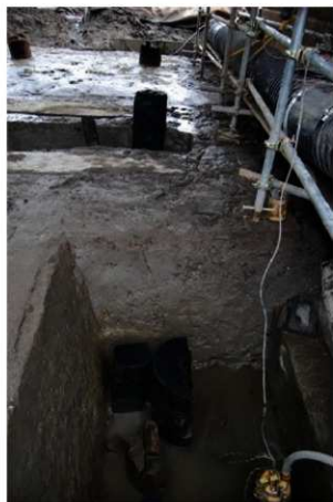
柱群(北西から)
