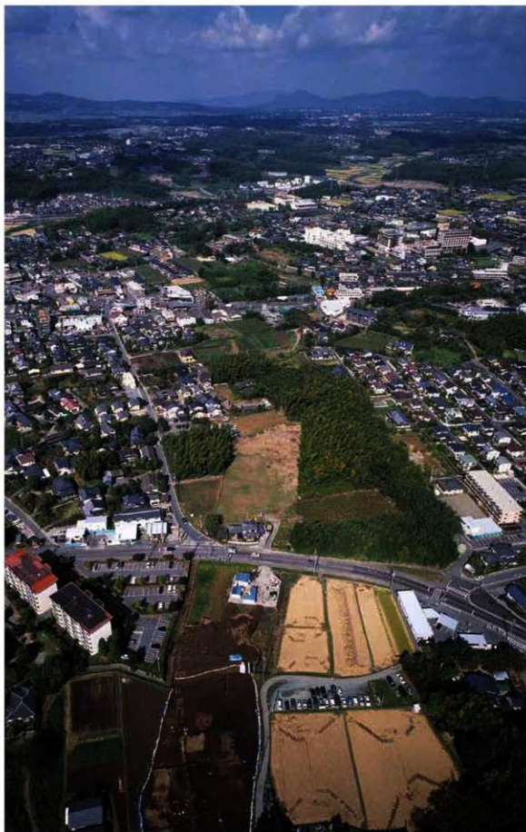
船入遺跡遠景（国道3号熊本北バイパス建設前）
