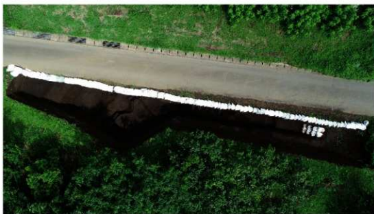
第3 調査区完掘状況
