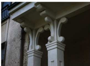
1階へラック柱頭飾り
