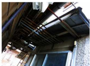
電気室から当初建物への引込電源 当時大容量の引込をしていた
