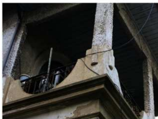
2階ベランダ窓と手摺
