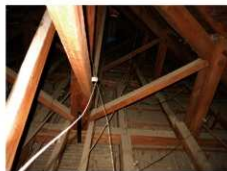
増築部洋トラス (キングポストトラス)
