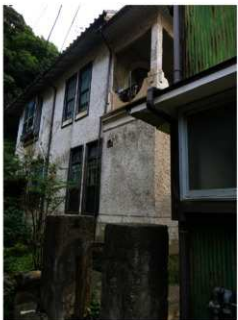
当初建物東面外観
