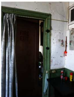
ダンスール非常口サイン
