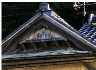
当初建物切妻部 破風板のデザインと持ち送り梁の化粧も優れている
