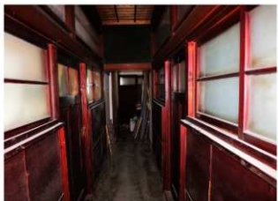
2階廊下の間仕切・明り取り
