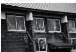
写真6 外壁板張・控壁
