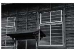
写真7 外壁節子下見板張・方柱外部
