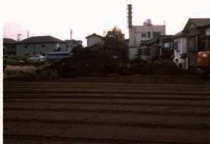
2. 表土剥ぎ風景
