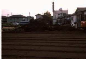
2. 表土剥ぎ風景
