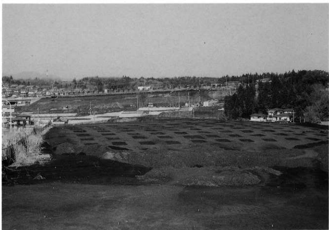
2 第Ⅱ区調査状況 (第Ⅰ区側より)
