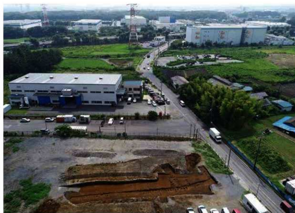
16次調査区遠景（北から）
