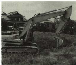
第2図 調査地点における試掘調査風景 (1991年9月)
