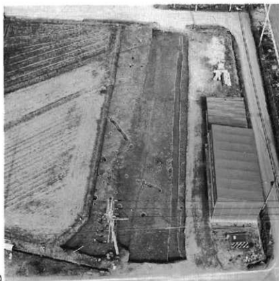
1. D地区 全景(南から)
