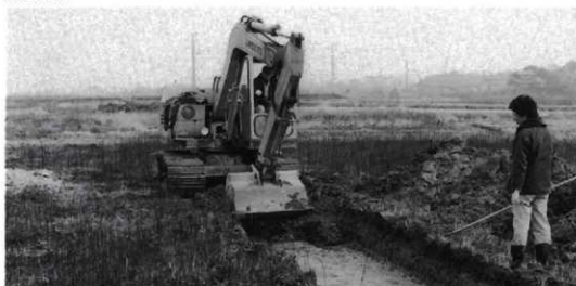
確認調査重機掘削
