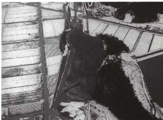
2. 北からの空中写真
