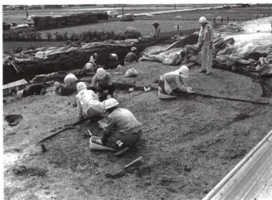
2. 1号住居跡掘削状況 北西から
