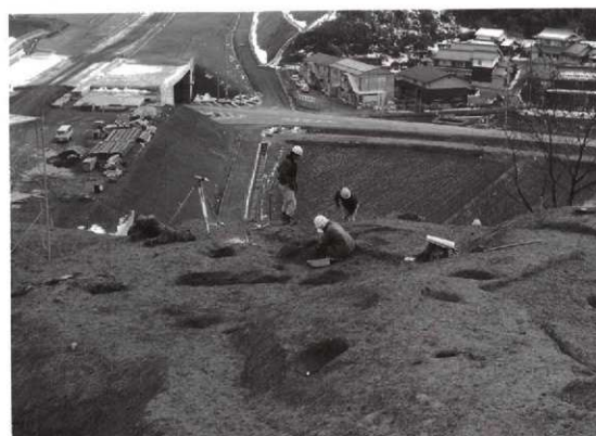
2. 第6 郭 (2号住居跡) 掘削状況 北から
