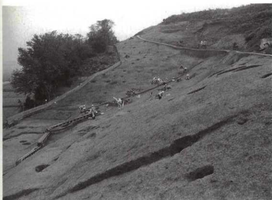
1. 斜面部掘削状況 北から
