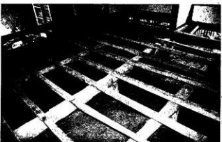
↑南東より ブツマ床板解体状態
