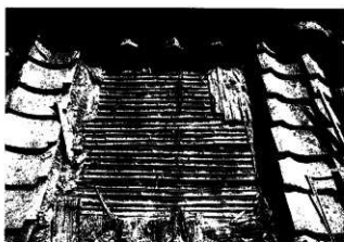
↑北より ダイドコロ瓦下屋工法の調査
