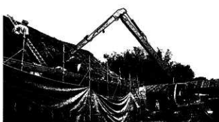
↑南西より 屋根トタン張り撤去状況、バックホウ使用
