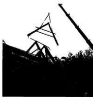
↑南西より 扱首組解体の状況、5トンクレーン使用
