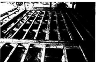
↑東より オザシキ床板解体状態
