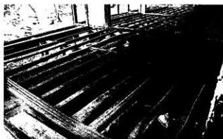
↑北東より カンジョウバ、オゲンカン、オザシキ床板解体状態
