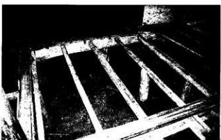
↑北西より オヘヤ床板解体状態。
