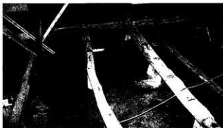
↑南より オゲンカン、オヘヤ根太解体状態。「ア」通りには足固貫を差通す
