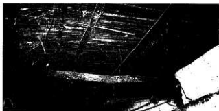
↑南東より カンジョウバて天井解体、簀子天井の状態。
