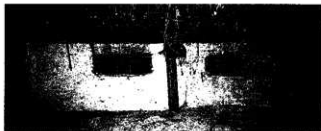
↑南より オヘヤ天井裏北側壁、換気用の下地板がある。「ヨ」通りの梁端部が残っている
