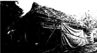
↑南西より 屋根トタン張り撤去、葺葺全景
