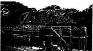
↑南東より 屋根トタン張り撤去、葺葺全景
