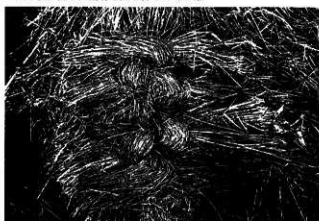
↑東より 藁葺棟の状態。束ねた藁を破掛けしている
