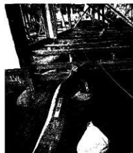
↑東より カンジョウバ、オゲンカン、オザシキ根太解体状態。「ワ5」柱根が束として残る
