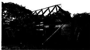
↑南東より 野地竹組解体、扱首組全景
