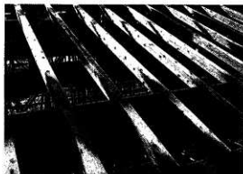
下屋部分の垂木と敷面戸
