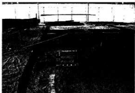
原寸平面図上に番付け部材を配置
