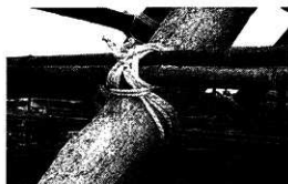
屋中竹は全て新材でφ75前後のものを2本組合せ、葺縄にて男結び結束している
