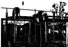
上屋部分 「5」通りの組立て
