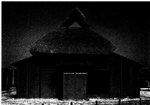
4 竣工 側面（西から）
