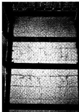
〔八〕 通り内部より荒壁の乾燥
