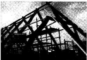
扱首材の建て込み
