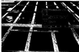
大引きの上に根太を450ピッチで配置
