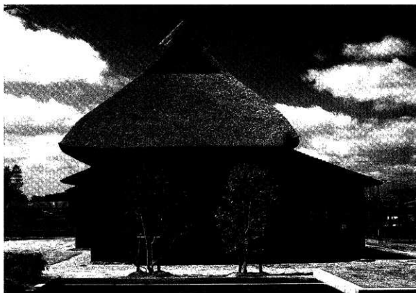
5 竣工 側面（東から）
