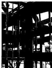
壁部分は力算が入って 補強されている
