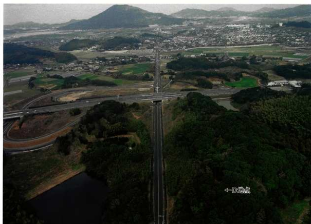
1-2 多久遺跡群遠景 D地点撮影前（南から）
