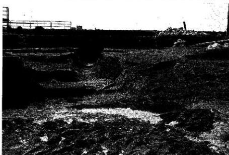
5-3 大溝完掘状況② (東から)
