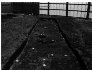
上層確認トレンチ (2M58~78)
