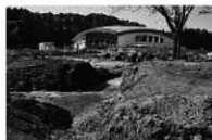
C区作業風景
