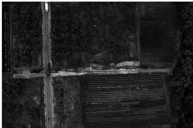
農道 25 号全景拡大 SW→
