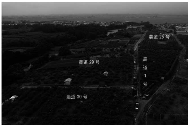
平成 22 年度調査路線全景 NE→
