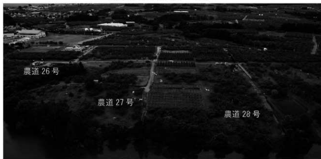
農道 26・27・28号全景 SE→
