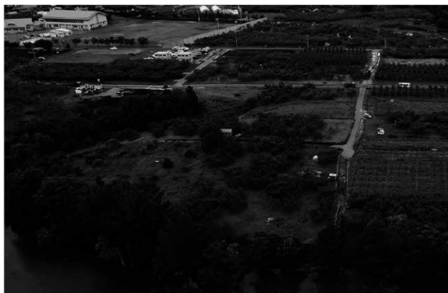
農道27号遠景 SE→
