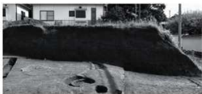
3. 調査区南壁土層①（北から）
