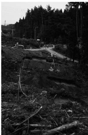
付替道路A作業風景 (N→)
