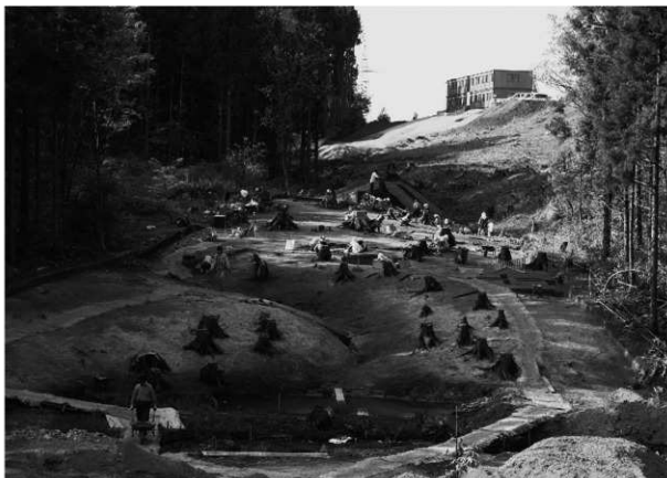
C区作業状況①(S→)
