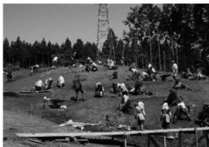
B区作業状況③(W→)
