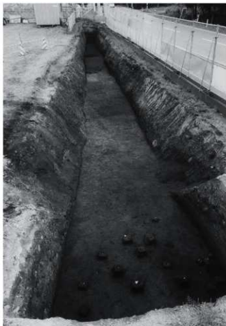
46 区道構検出状況 南西から
