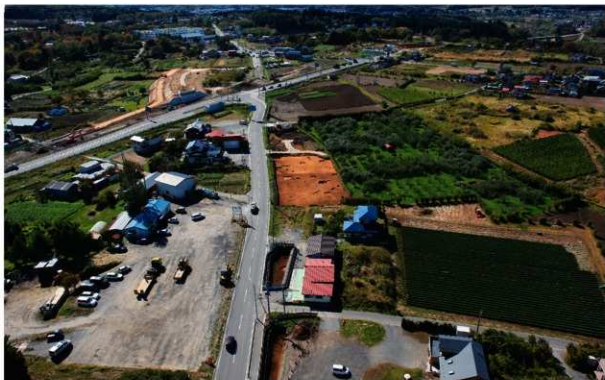
北東から調査区を望む（左中から右上にのびるのが八戸南環状道路）
