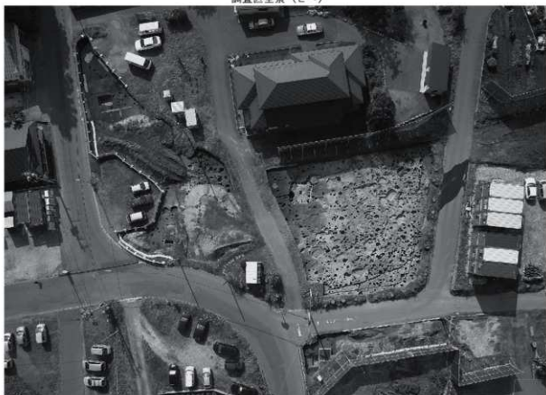
C・D区全景 (真上から。写真上が南)
