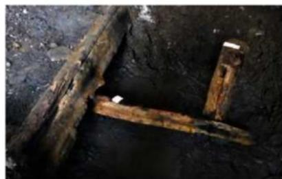
▲石垣下の基礎構造 左側が桐木と割材、右に控木と控杭。割材が黒ずむ箇所と、控木が黒ずむ箇所はボルト状の金具が貫通している。金具はほぼ錆びてしまっており、良好な状態で抽出できたのはごくわずかである。
