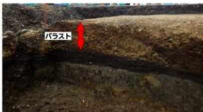
▲築堤の上端(C区) 築堤の上には黄色い砂利が残っている。残り具合は調査地点により異なるが、2街区はよく残り20～30cmほどが確認されている。開業に伴うバラストと考えられる。
