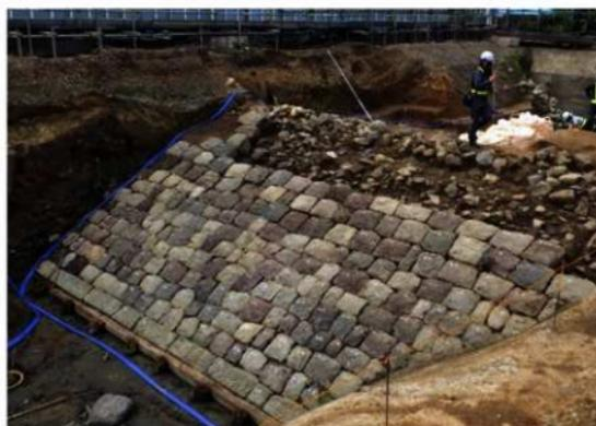
◀海（東）側の石垣 石垣下端は角材の胴木を連結させ、その前に留め杭を幅90cm間隔で打って押さえている。根石の上に最大で14段の築石が残っていた。築石は四角錐形の間知石の控えを打ち欠いており、断面が台形となっている。石を貼り付けたような状態である。
