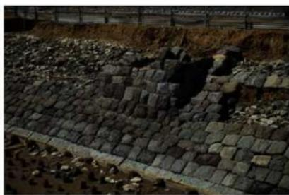
▲張り出し遺構（E区）海（東）側石垣の一部を張り出し状にしている。幅は3.3 mほどで5段の石積みが残るが、本来は道床と同程度の高さであったものと考えられる。1.3 kmの海（東）側の石垣ではこの一基が確認されているだけである。
