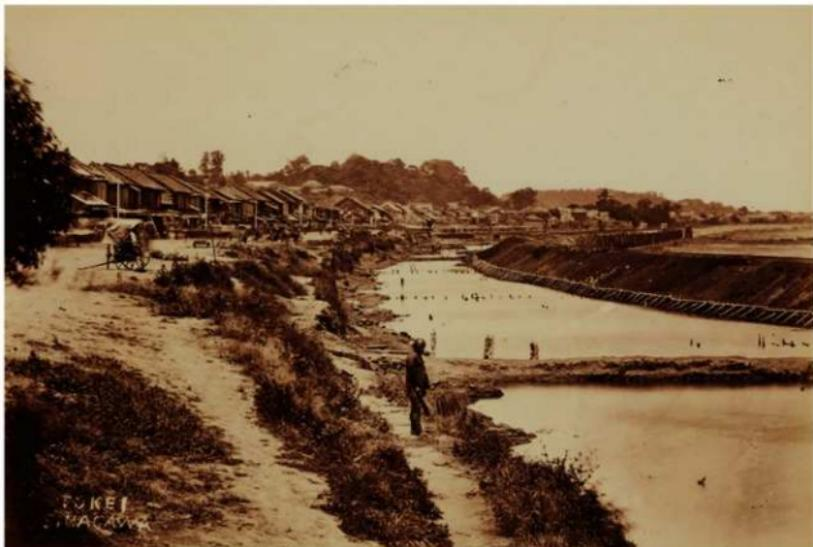
▲ 高輪の築堤工事（日本大学芸術学部蔵）左が旧東海道、右が工事途中の高輪築堤。要所に東海道と築堤を結ぶ小堤がつけられた。海上に築かれた築堤は、頻繁に高波の被害を受けたため、工事は難航した。この写真はオーストリア人写真家・ミヒャエル・モーザーが撮影したもので、工事の高輪築堤の姿を伝える数少ない資料である。
