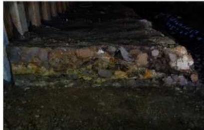
▲築堤海（東）側の埋め立て土 一帯は明治時代末から着手された、品川駅改良工事により埋め立てられた。工事にあたり、大型重機が用いられるようになったため、埋め立て土中には、築堤本体の盛土には見られない、大型の粘土ブロックが混じるようになる。
