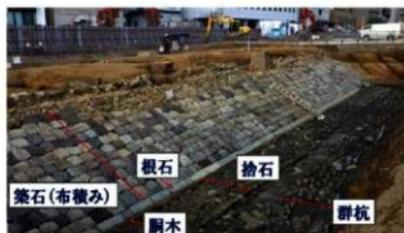
▲海(東)側の石垣の構造(B区) 石垣の土台は、桐木が敷かれ、桐木の上に長手の直方体の根石を置き、築石を積んでいる。積み方は横に目地が通る布積みである。石垣の前面には幅2mほど土丹の捨石が敷かれ、そのさらに海手側に4列の群杭が打ち込まれている。
