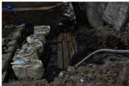
◀3線化時の山（西）側石垣 築堤は明治9年（複線）と明治32年（3線）に、いずれも山（西）側に拡幅されており、その段階を捉えることが出来た。写真左が開業期の山（西）側石垣、写真中央が3線化時の石垣と考えているもので、4枚の胴木の上に築石を積み上げている。
