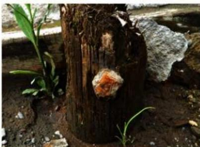
▲留め杭に使われたボルト状の金具 石垣下端の脚木を抑える留め杭にはボルト状の金具を使い、留め杭と脚木及び割材を貫通させて固定している。写真中央のサビの塊が、方形のナット部分である。すべての留め杭に確認できる。
