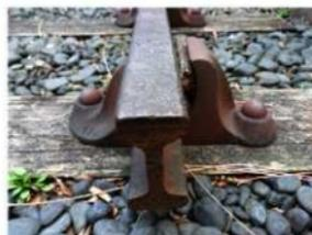
◀旧新橋停車場跡に復元されている線路 双頭レールをチャーに嵌め込み、木製の楔を噛ませて使用した。復元では枕木が露出しているが、開業時の線路は枕木もバラストに覆われ、レールの上部だけが見えている状態であったようである。
