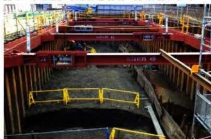
◀築堤の芯と土留め遺構(P10橋脚部、北から) 環状4号線の橋脚部、南北長約38m×東西幅約8mの範囲にシートパイルを打ち、切梁をかけての調査である。中央に蒲葦状に盛り上がる盛土が築堤の芯に相当するもので、右側の板と杭で盛土を抑えている。左側シートパイルの外に海(東)側の石垣が残っている。
