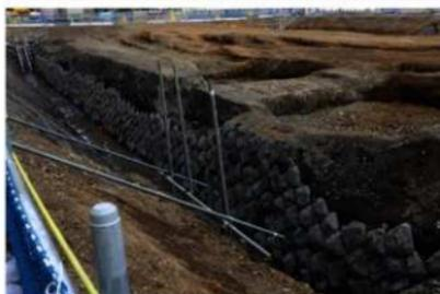
▲ 3線化の拡張期の石垣（B区）明治32年、線路を増線するため、築堤は西（山）側に拡張される。これに伴い新たに作られた石垣である。間知石を斜めに使う谷積みによって直立気味に構築されている。
