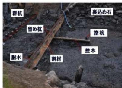
▲海（東）側の石垣の基礎構造 石垣を取り除くと胴木の内側に割材を付けていた。この割材によって根石に角度をもたせている。さらに、留め杭の下部には控木と控杭とで固定させ、その上を分厚い裏込め石で覆っていた。確認した1～4街区のすべての海（東）側の石垣がこの工法でつくられている。
