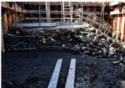
▲築堤裁ち割り状況 写真右が海（東）側の石垣とその裏込め石。他の調査区と同様に、石垣上部はすでに失われており、下部の8～9段が残存していた。
