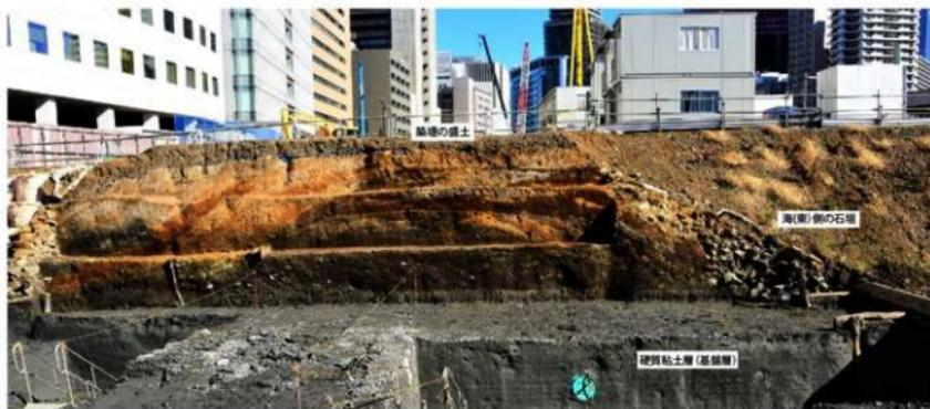
▲築堤の基盤層（C区）築堤の基盤層は灰色の硬質粘土層で、分厚く堆積し固く締まっており、上面は水平である。石垣を支える留め杭や群杭はいずれもこの土層に打ち込まれている。
