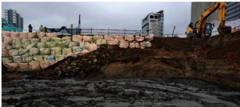
▲築堤の裁ち割り（北から）調査にあたっては、一定間隔で遺構の裁ち割りを行い、都度内部構造と掘削手順の確認を行った。写真は C 区の南端部で、写真左が海（東）側の築石とその裏込めにあたる。山（西）側の石垣は調査区外のため確認できていないが、残存している可能性は十分に考えられる。海（東）側石垣奥の大型土嚢は、法面保護のために積み上げられたもので、そのさらに奥が第 7 橋梁橋台部を含む史跡指定範囲である。
