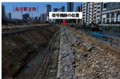
▲南北方向にのびる築堤の姿（A区から南を見る）海（東）側の石垣の前面に群杭が並列して伸びている。張り出し遺構は、直線的に延びる築堤が東へ緩やかに湾曲する位置で確認された。
