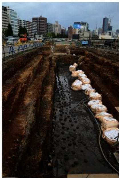
▲海(東)側の石垣の前面に打たれた群杭(仮ベント部、南から)4列の杭列が南北方向のびて確認された。杭の確認面の高さはT.P.-1.0mである。写真左の階段状の土層は、明治末からはじまる品川駅改良工事の埋め立て土で、これによって築堤は埋め立てられている。
