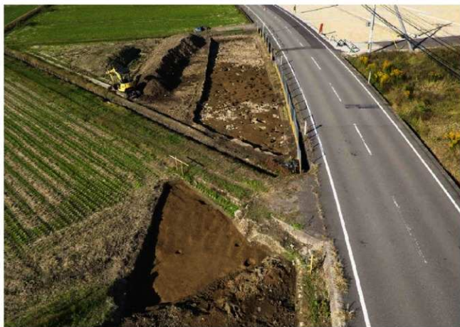
令和3年度調査 2-1区全景航空写真（南から）
